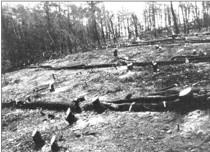
Εικόνα 1. Κορμοδέματα που κατασκευάστηκαν τον Ιανουάριο 1997, σε πειραματική επιφάνεια που είχε καεί στις Ροβιές, Εύβοιας, τον Ιούλιο 1996.
